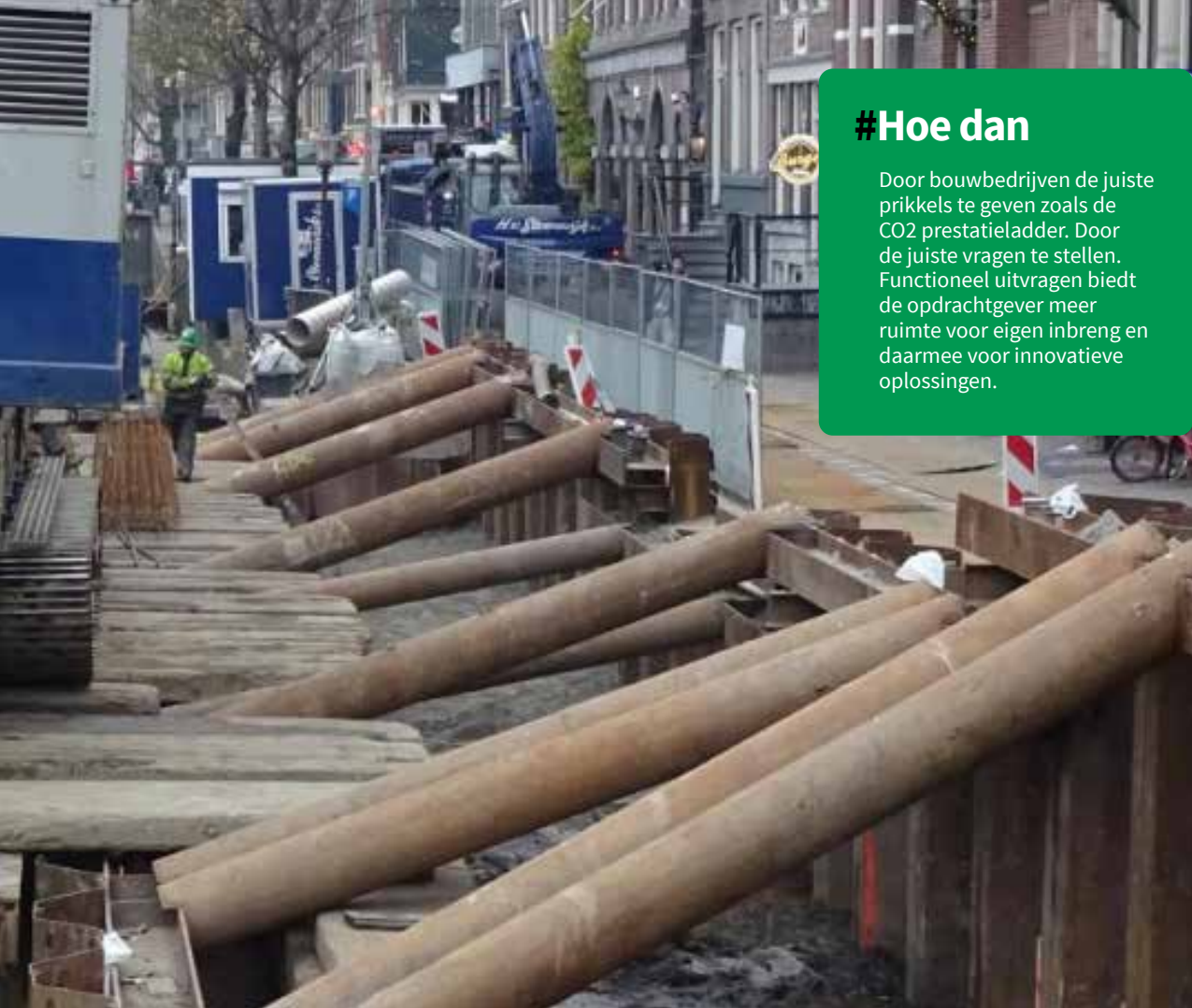
Renovatie van kademuren
