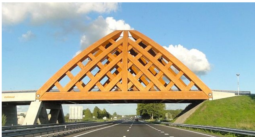
Figuur 4.2 Accoya® brug in Sneek
