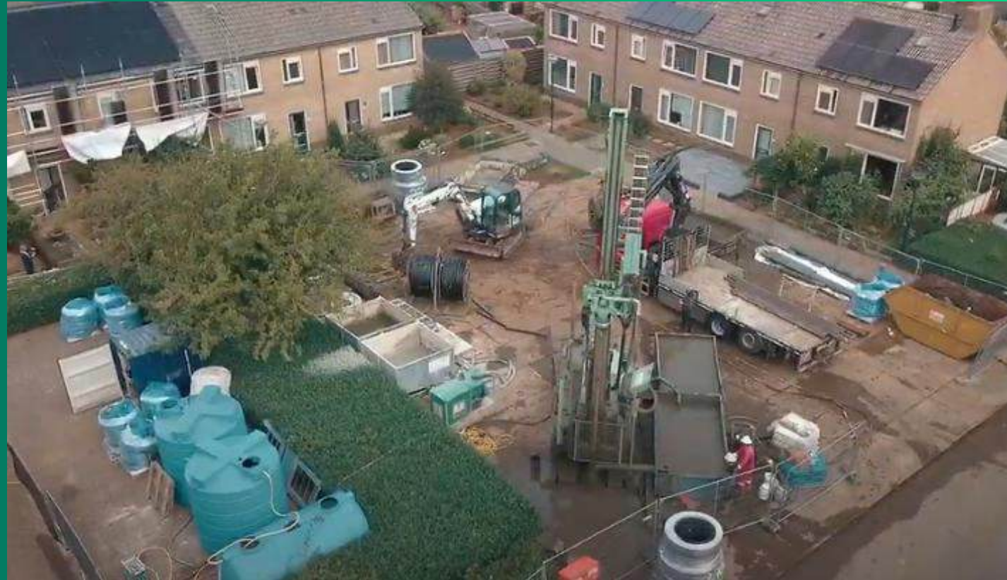
Project Wonion; warmtepompen voor 12 woningen, Terborg
