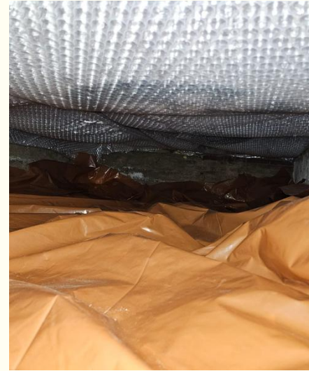
KRUIPRUIMTE ISOLATIE OUDEWATER
