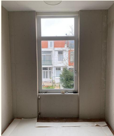
BINNENGEVEL ISOLATIE UTRECHT
