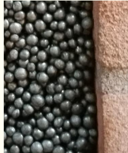
SPOUWMUUR ISOLATIE WOERDEN
