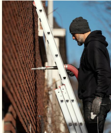
SPOUWMUUR ISOLATIE BREUKELEN
